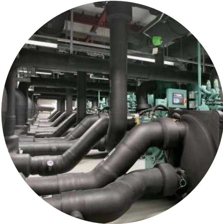
La manta de espuma elastomérica es un material especialmente diseñado para el aislamiento térmico. Ayuda en el control de la condensación en diversas aplicaciones, fabricada con elastómero flexible de goma de nitrilo, esta manta no solo garantiza un aislamiento eficiente de la temperatura, sino que también proporciona una notable resistencia al paso del vapor de agua.
